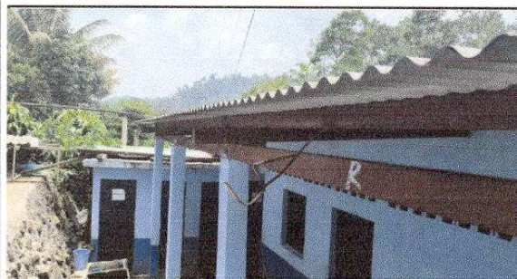
FOTO 3: Sustrucción de canal de metal, Reparación de bajada de agua pluvial, tubo PVC 3" Y Sustrucción de soporte o pescante de metal para canal
