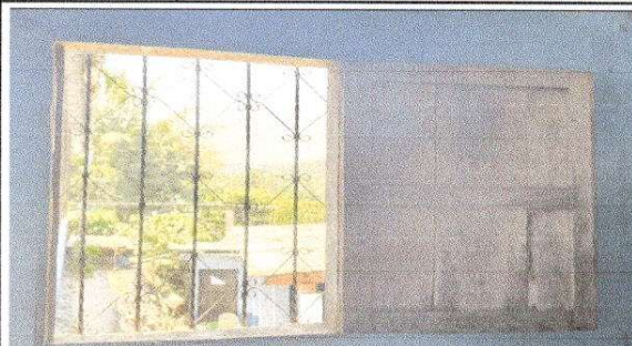
FOTO 1: Sustrucción de ventanas de madera por metal mas vidrio
