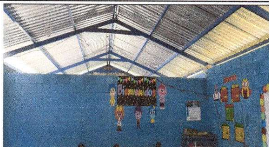
FOTO 7: Sustitución de focos ahorradores
