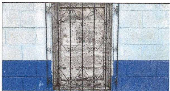
FOTO 5: Pintura en muros exteriores
