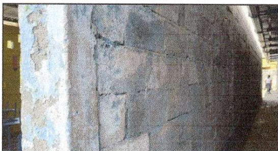
FOTO 11: Repello en muro
