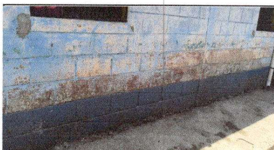
FOTO 4: Pintura en muros exteriores
