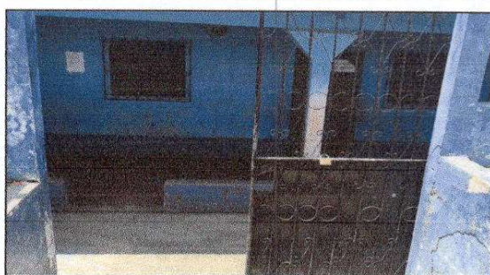
FOTO 10: Fabricación e instalación de portón de metal de ingreso
