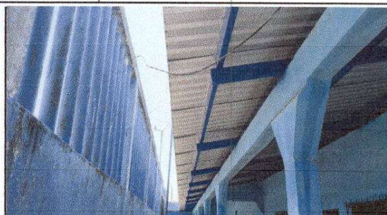
FOTO 2: Sustrucción de canal de metal, Reparación de bajada de agua pluvial, tubo PVC 3" Y Sustrucción de soporte o pescante de metal para canal
