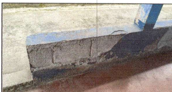
FOTO 12: Repello en muro
